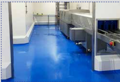
PolySto IP40RB Natural sur un sol en résine, avec une gorge pour la remonté en résine dans la banquette.
