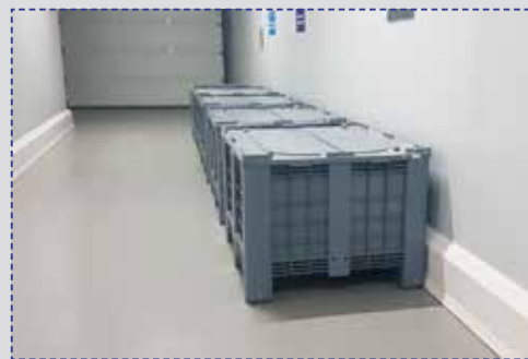
PolySto IP40F SaniCoat installée sur un sol en résine
