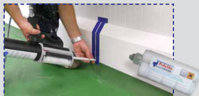
PolySto OP30RB SaniCoat avec une gorge pour la remonté de résine dans la banquette. Finition avec PolySto HygiSeal.
