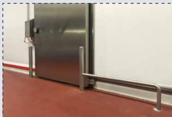
PolySto Edelstahlpoller und -barriere im betonboden eingebaut.
