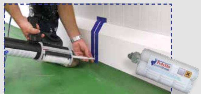
PolySto OP30RB SaniCoat mit einem Epoxyboden in die Aussparung eingearbeitet und HygiSeal Fugen.
