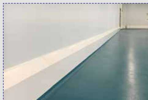
PolySto IP40RB SaniCoat mit Epoxy-Fussboden in die Aussparung eingearbeitet..
