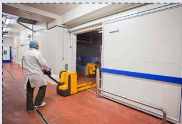
PolySto Edelstahlpoller und -barriere im betonboden eingebaut.
