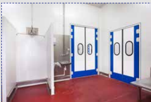
PolySto OP20F Inox montiert auf einem Betonboden.
