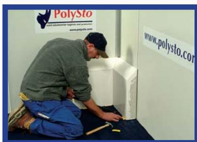
Le montage s'entame toujours par la pose des pièces de finitions et les coins intérieurs/ extérieurs.
