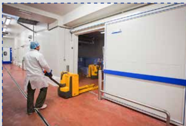
PolySto wbudowane w posadzkę odboje rurowe i słupki wykonane ze stali nierdzewnej
