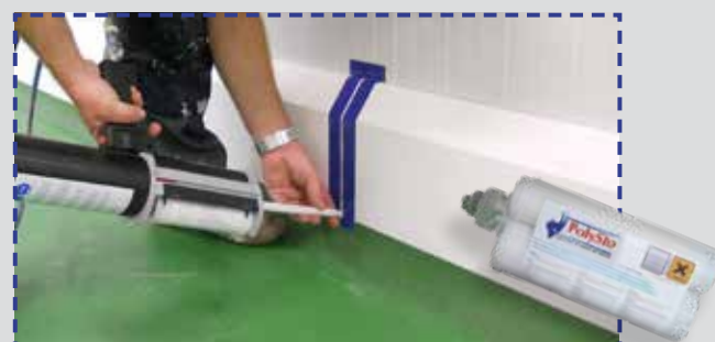
Cokoły PolySto OP30RB Sanicoat z podcięciem na epoksydową posadzkę i wykończone masą PolySto Hygiseal.
