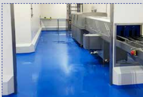
PolySto IP40RB Natural z podcięciem i zaaplikowanym w nim żywnym wykończeniem
