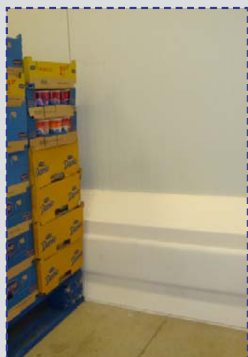
PolySto OP30F instalované na keramickou dlažbu, na přání s ochranným systémem Extreme impact (samolepicí).
