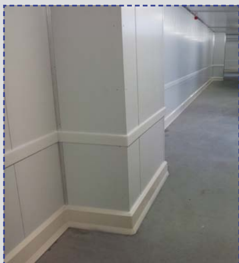
PolySto sokly OP20F instalované na betonové podlaze s bílou PE ochrannou lištou.
