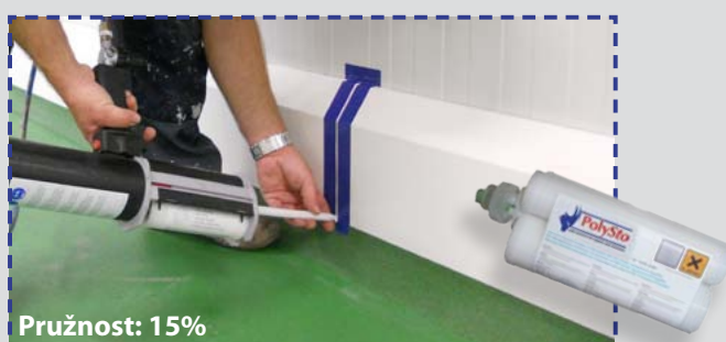
PolySto sokl OP30RB Sanicoat s podlahovým čistitelným rádiusem vytaženým do soklu a začištěné tmelem Saniseal.
