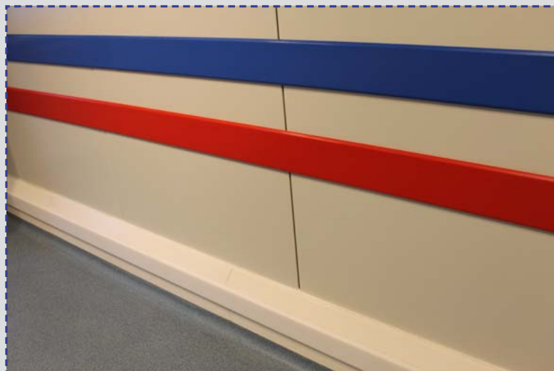
PolySto OP30RB (экстрим защита) с эпоксидным полом, залитым в выкружку, и красная и голубая PE защитные полосы.
