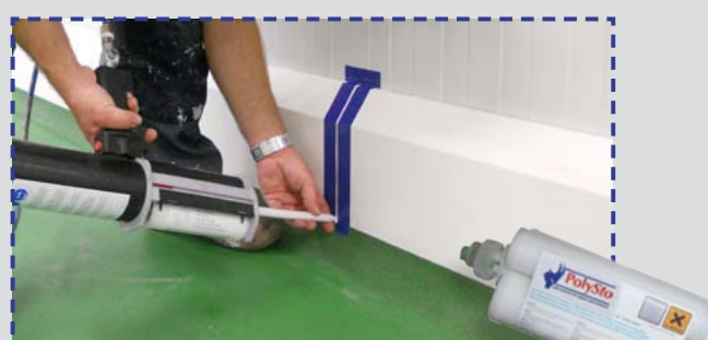
PolySto OP30RB Sanicoat с эпоксидным полом, залитым в выкружку, с PolySto Saniseal.
