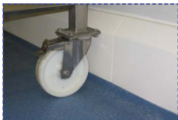
PolySto OP30RB Sanicoat с эпоксидным полом, залитым в выкружку
