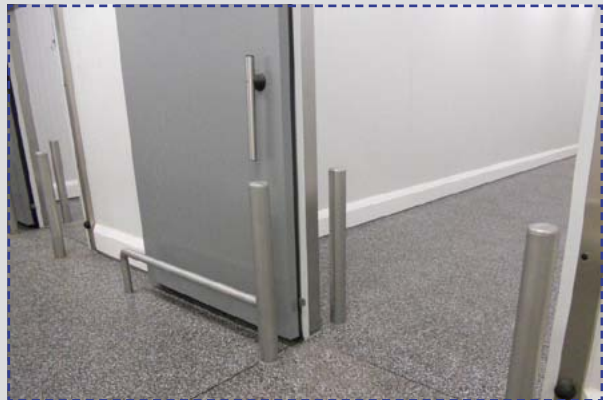
PolySto отбойные стальные защитные барьеры и OP30RB Sanicoat с гранитным полом, залитым в выкружку плитуса.
