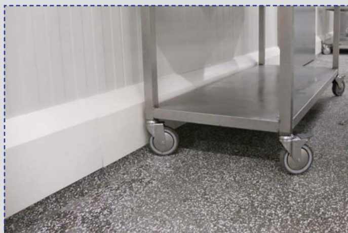
PolySto OP30RB и гранитный пол, залитый в выкружку.
