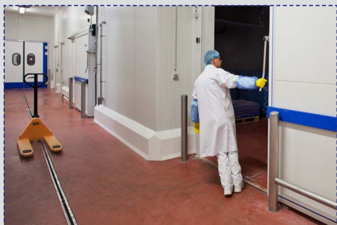
PolySto IP40F Sanicoat и PolySto отбойные столбики и барьеры на бетонном полу.
