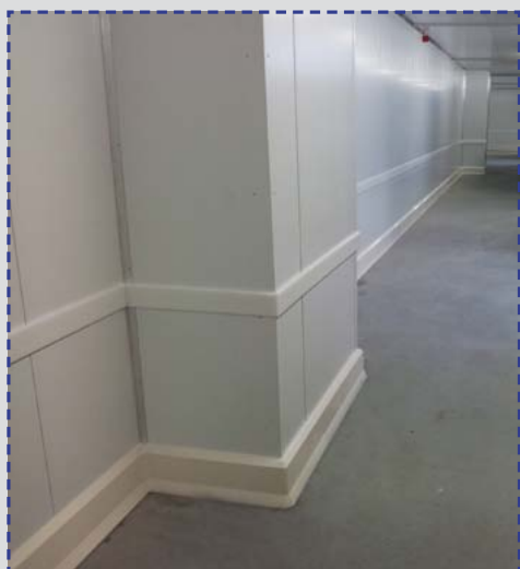
PolySto OP20F įrengtos ant betoninių grindų su PE juosta.
