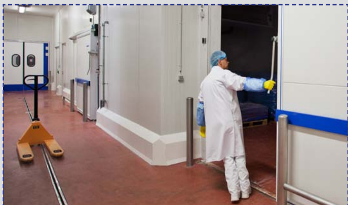
PolySto IP40F Sanicoat grindjuostės ir nerūdijančio plieno apsaugos ir barjerai įrengti ant betoninių grindų pagrindo.
