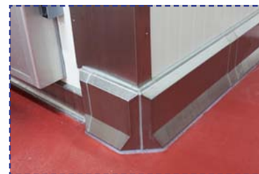
PolySto OP20F inox instalata pe o pardoseala epoxi deja realizata .
