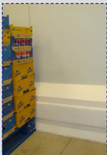
PolySto OP30F cu optiunea impact extrem (autoadeziv) montata pe placi ceramice.
