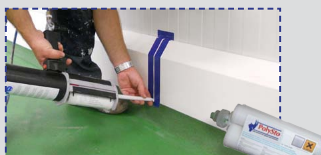
PolySto OP30RB Sanicoat cu degajare pentru racordarea cu pardoseala in forma de scafa. Finalizat cu PolySto Saniseal.
