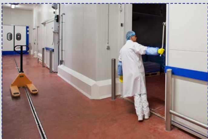
PolySto IP40F Sanicoat montata pe pardoseala de beton cu stalpi si bariere de protectie din inox.
