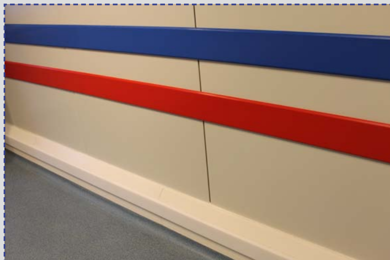
PolySto OP30RB (cu optiunea impact extrem) cu degajare pentru ridicarea pardoselii in forma de scafa. La parte de sus benzi de protectie din polietilena rosie si albastra.
