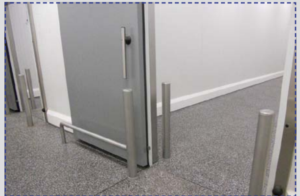
Protectii PolySto din inox tubulare, carotate in pardoseala si cu rezervare pentru racord cu rasina.
