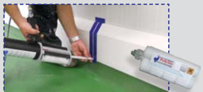
PolySto OP30RB Sanicoat grindjuostė sujungta su epoksidine grindų danga, suformuojant jungiamąją grindjuostę, bei sandarinant su PolySto Saniseal hermetiku.
