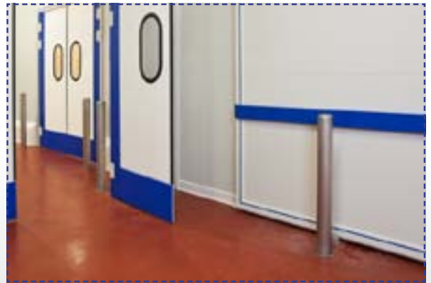
PolySto nerūdijančio plieno apsaugos ir OP10F grindjuostės įrengtos ant betoninių grindų.
