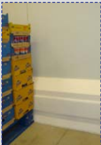
PolySto OP30F įrengta ant plytelėmis dengtos grindų dangos, atlaikantis ekstremalius poveikius (Selfadhesive- savaime prilimpantis).
