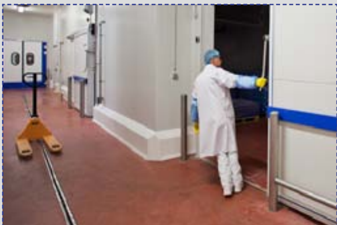
PolySto IP40F Sanicoat grindjuostės ir nerūdijančio plieno apsaugos ir barjerai įrengti ant betoninių grindų pagrindo.
