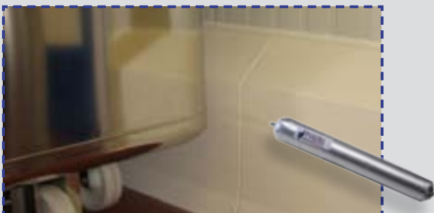
PolySto OP30F įrengtas ant betoninių grindų paviršiaus, užsandarinti su maisto poveikiui atspariu hermetiku.
