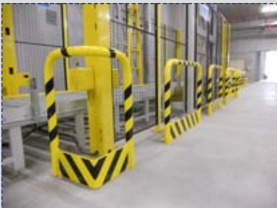
PolySto PMA (kairėje) ir PML (dešinėje) montuojama ant betoninių grindų.
