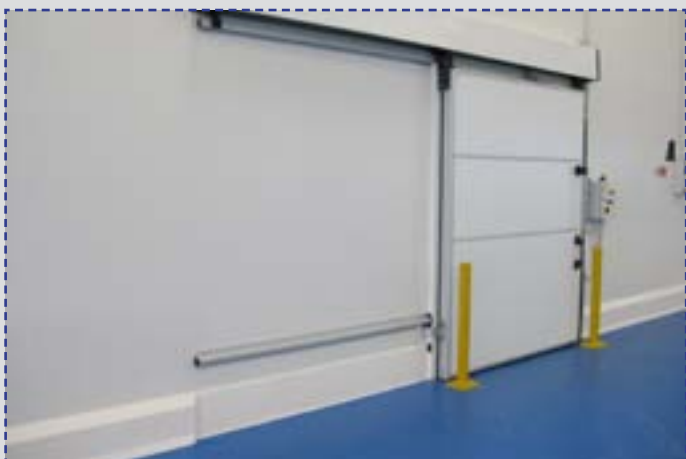
PolySto OP30F, OP30SF Sanicoat ir poliuretano apsaugos įrengtos ant epoksidinės grindų dangos.
