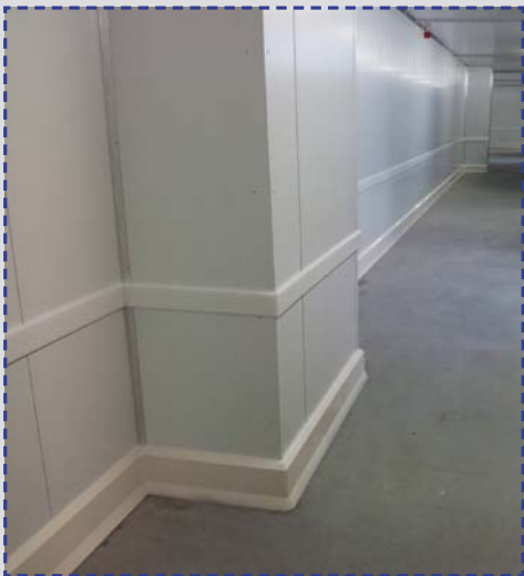
PolySto OP20F aplicado num pavimento de betão com faixa de PE.
