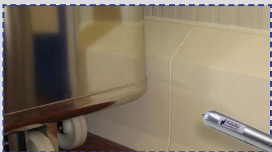
PolySto OP30F aplicado em pavimento de betão com acabamento com selante PolySto Food Safe.
