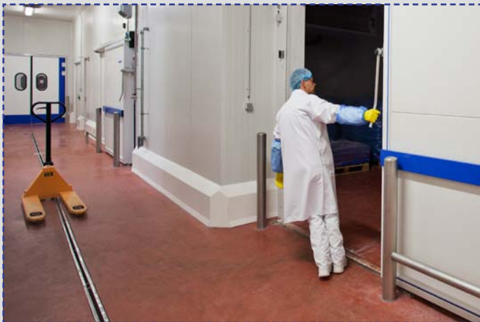
PolySto IP40F Sanicoat aplicado em pavimento de betão e postes e barra de aço inoxidável construídos em pavimento de betão.
