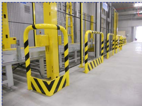
PolySto PMA (esquerda) e PML (direita) aplicados num pavimento de betão.
