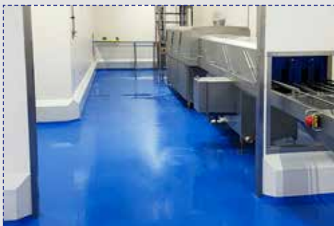
PolySto IP40RB Natural con piso de epoxy integrado en el hueco.
