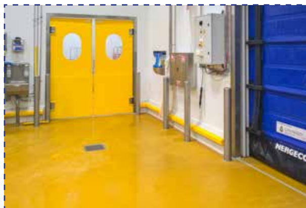
Postes de seguridad PolySto en inox anclados en el piso de hormigón
