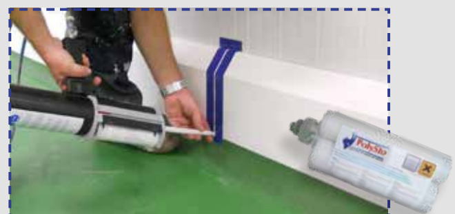
PolySto OP30RB SaniCoat con un piso de epoxi incorporado en el hueco y agregue HygiSeal.
